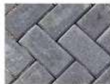
waterpasserende betonsteen parkeerstroken en -pockets
